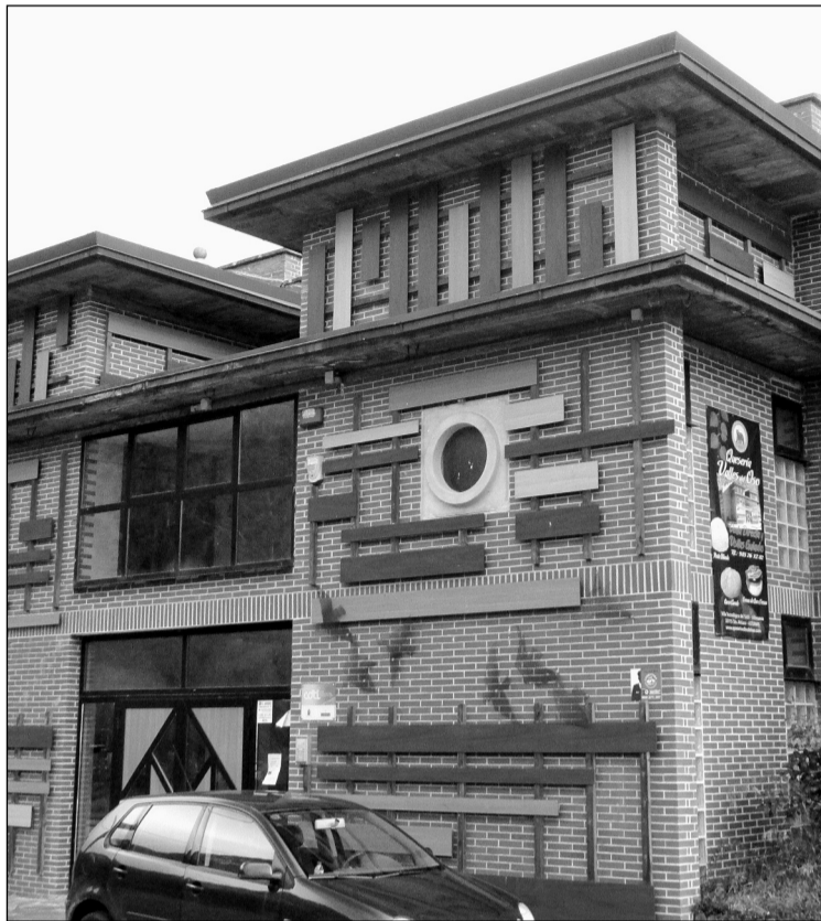
Fachada del centro de empresas de El Sabil
