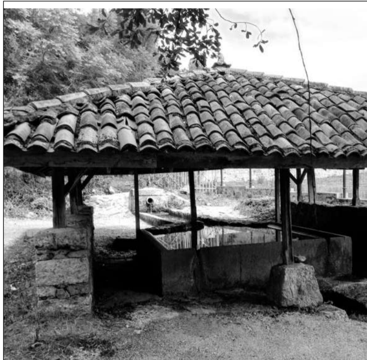
'Lavadero de Piñera tras los trabajos de rehabilitación
