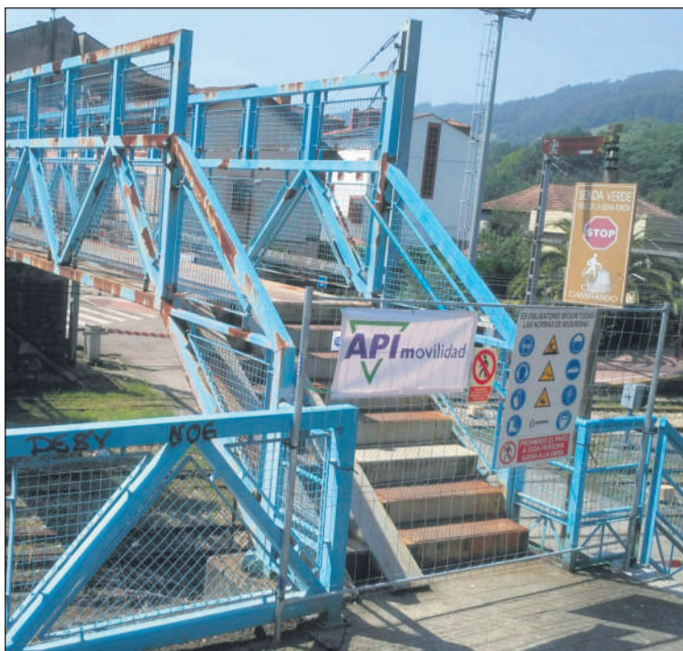
La pasarela con el cartel de las obras/ Valentín Álvarez
