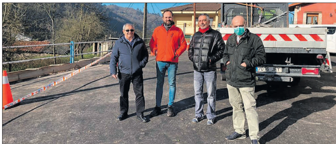
Los concejales Luis Pacho y Alfonso Pereira, con los vecinos, en el inicio de las obras
