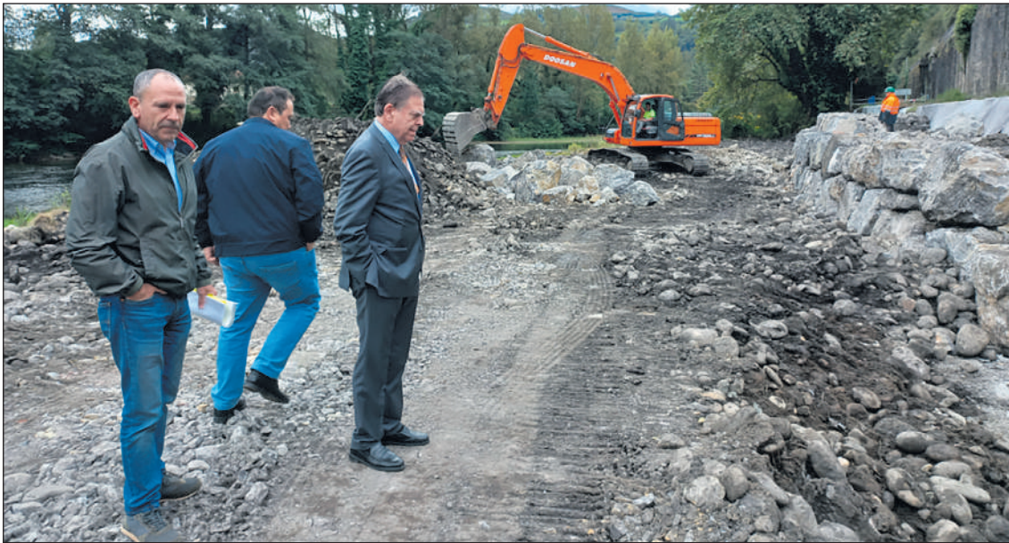
El alcalde, Alfredo Canteli, junto a dos trabajadores municipales, en la visita a la obra
