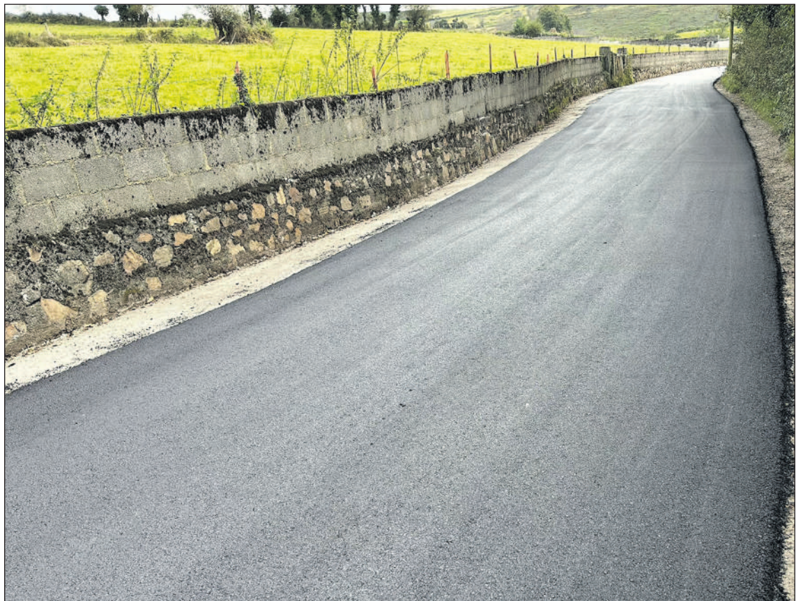
Detalle de la pavimentación del camino de El Crucero
