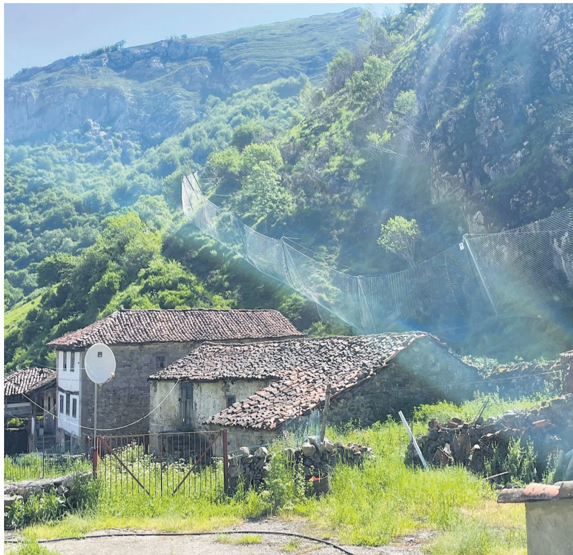
La barrera, con capacidad para absorber hasta 1.000 kilojulios de energía
