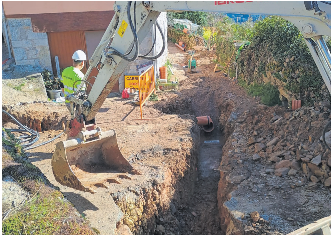
Excavación del colector principal
